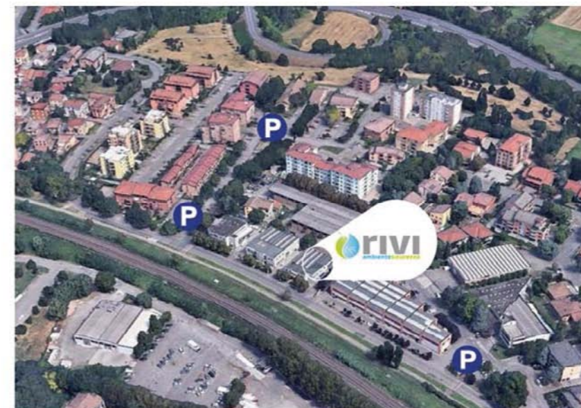
Sede RIVI in Via Ferravilla 21
